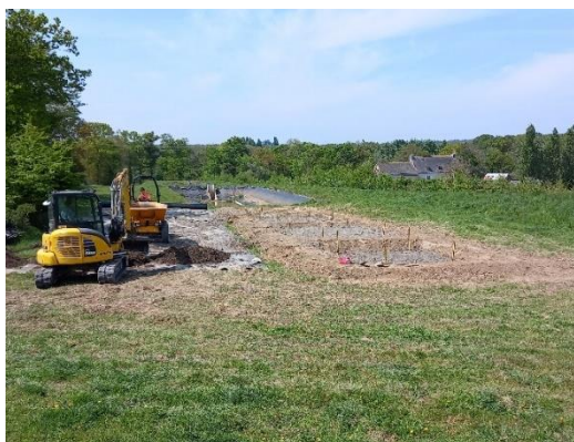
Figure 14 : mise en œuvre des parcelles - homogénéisation des matériaux (phase 1), remplissage des parcelles (phase 2) et vue d'ensemble des parcelles expérimentales
